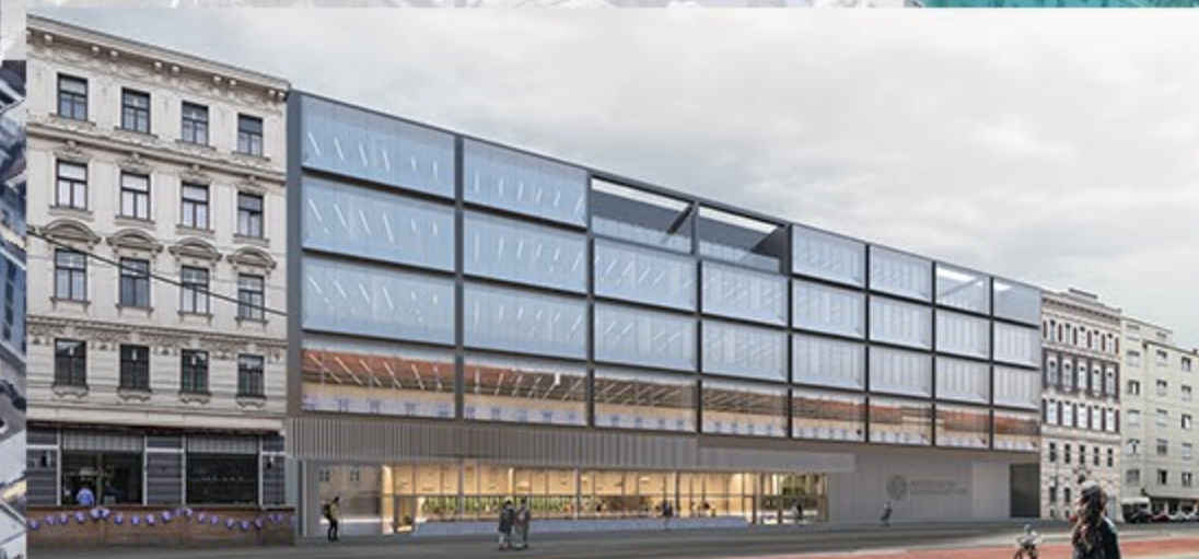
MedUni Campus Mariannengasse Fertigstellung 2026
